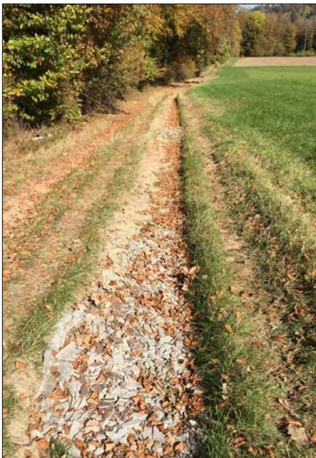
Chemin communal remblayé avec des déchets d'Eternit. L'analyse de ces déchets découverts récemment à Chavannes-sur-Moudon par M. Philippe Pichon, traqueur d'amiante, a révélé qu'ils contenaient, non seulement de l'amiante chrysotile, mais du crocidolite !
