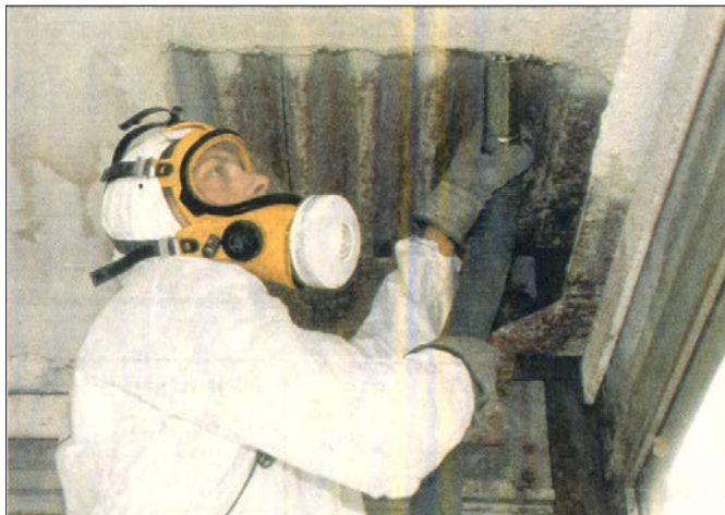
Déflocage de la Tour métallique des IRL en 1993
