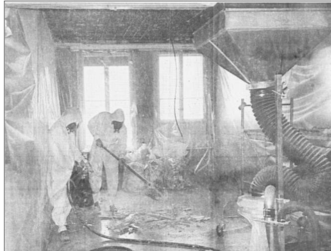
Des désamianteurs en scaphandre tentent de réparer les dégâts
