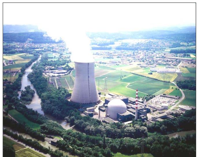
Centrale nucléaire de Gösgen. Son refroidissement devait être assuré par pompage de l'eau de l'Aar. Pour des raisons de pollution thermique de ce fleuve, le recyclage de l'eau des réacteurs a dû être assuré en construisant cette tour de refroidissement haute de 150 mètres, soit plus de 50 étages.
