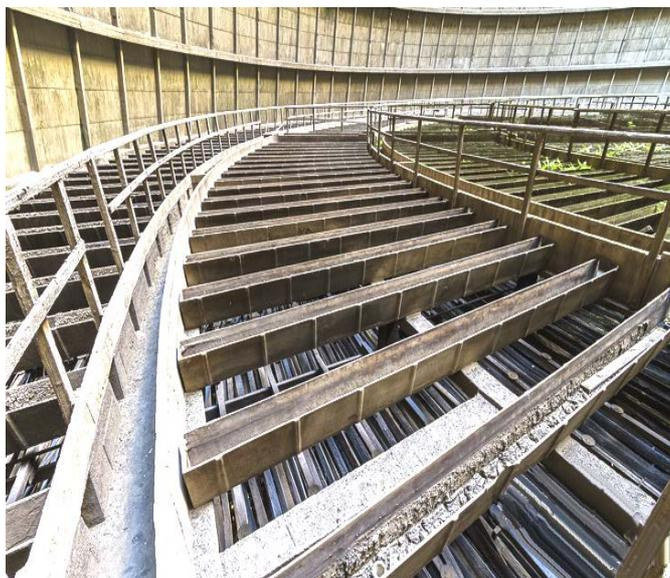
Sur cette photo prise dans une tour de refroidissement, on distingue le réseau de canaux de distribution de l'eau bouillante qui l'asperge sur les plaques de ruissellement où elle condense puis ruisselle dans le bassin de récupération d'où elle est pompée dans le circuit du réacteur pour le refroidir.
