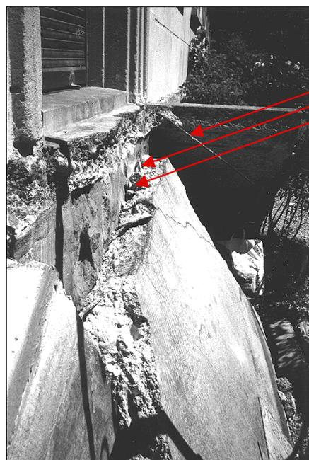
Effondrement d'une dalle de balcon en porte-à faux en béton armé suite à la carbonatation du béton et à la corrosion destructive de ses fers d'armature.
