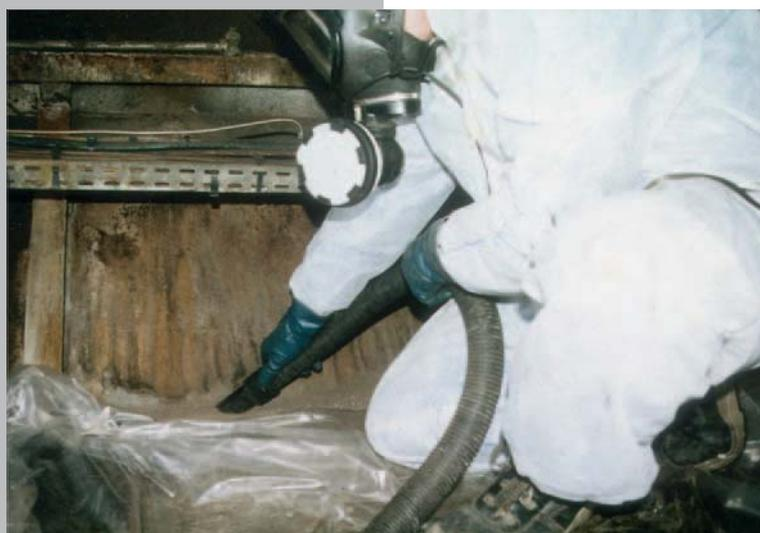
Les électriciens interviendront ensuite avec une protection des voies respiratoires de type jetable FFP3 ; en fin d'opération, ils mettront en place des coquilles de protection thermique des câbles, sans amiante.
