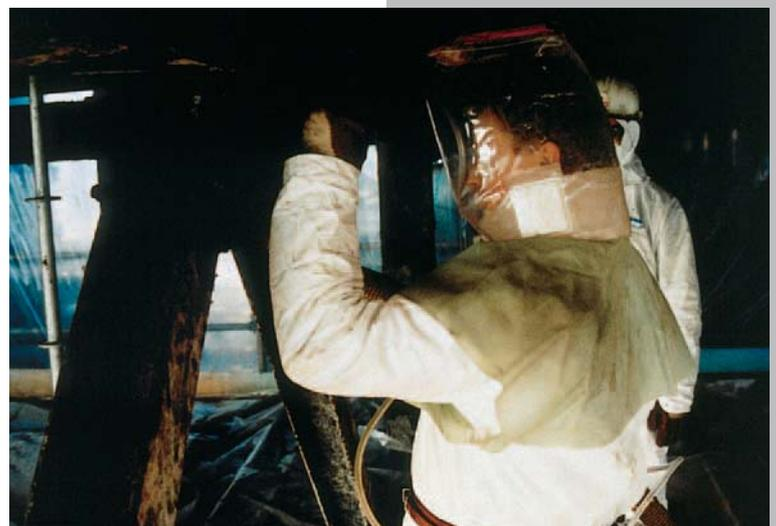
Appareil isolant à adduction d'air comprimé avec masque complet
