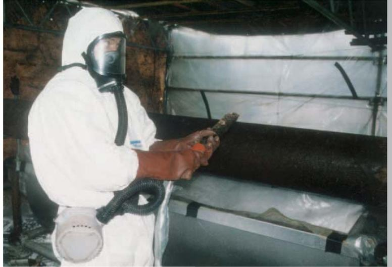
Afin que l'utilisateur dispose d'une quantité d'air suffisante, lorsqu'une opération demande un effort physique intense, un débit de 160 litres par minutes à l'inhalation est nécessaire sur les appareils à ventilation assistée.
