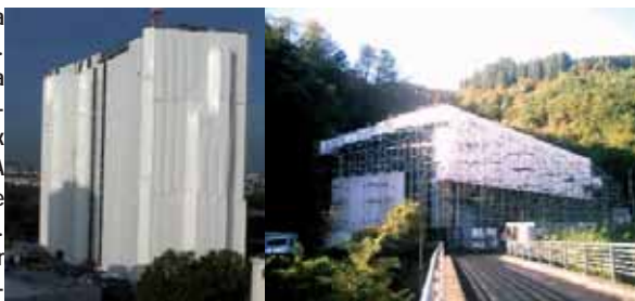
Chantiers déjà réalisés: Mise sous confinement de la Cité de l'Air (Paris 15) et du Centrale hydraulique EDF Gollnhac
