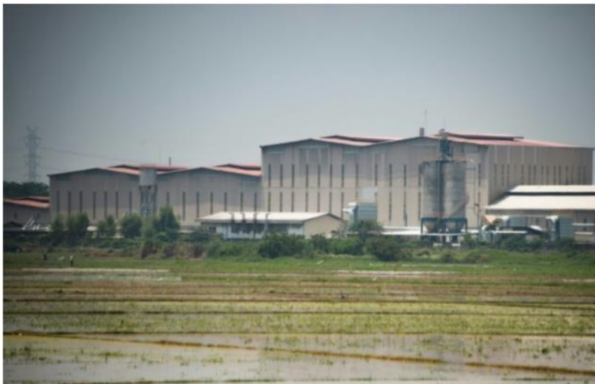
Des rizières entourent une usine de fabrication de produits à base d'amiante à Cikarang, dans la province de Java-Ouest, le 24 octobre 2017 en Indonésie Photo BAY ISMOYO. AFP
