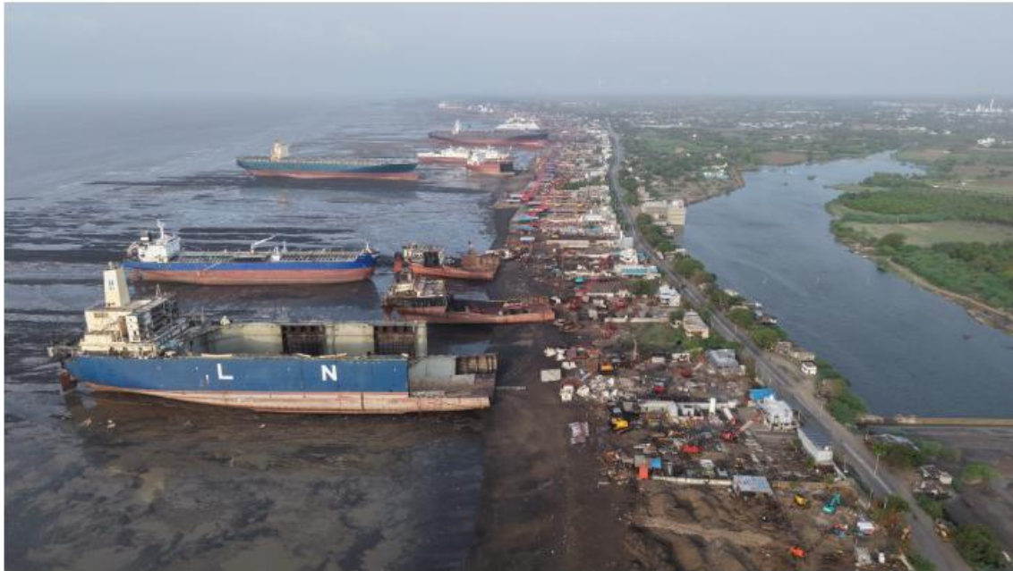
Chantiers de démolition navale à Alang-Sosiya, Gujarat, Inde. juillet 2026 © ONG Plateforme de démantèlement de navires
